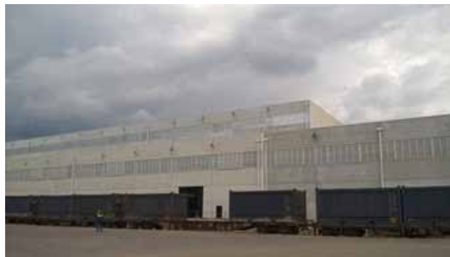
Pavimentazioni area laminatoio
