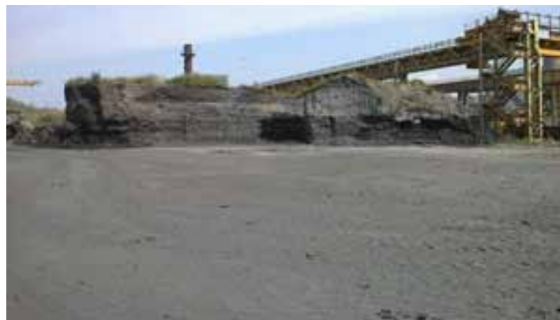
26/05/2016 – Avanzamento rimozione cumulo storico
