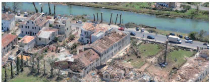
Danni prodotti dal tornado a Cazzago (VE), foto Vigili del Fuoco
