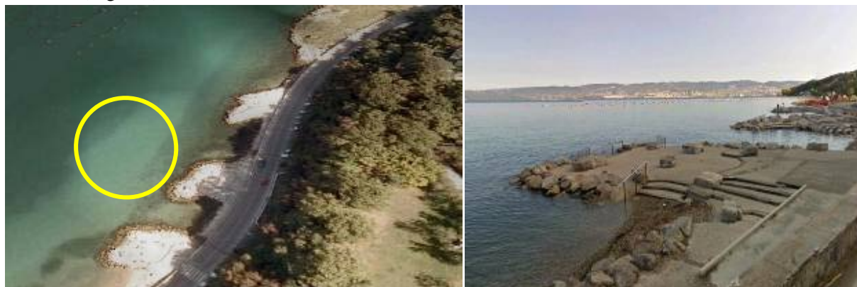
Figura 5.2 – Punta Sottile, terrazza mare, stazione 1161, comune di Muggia, provincia di Trieste.
