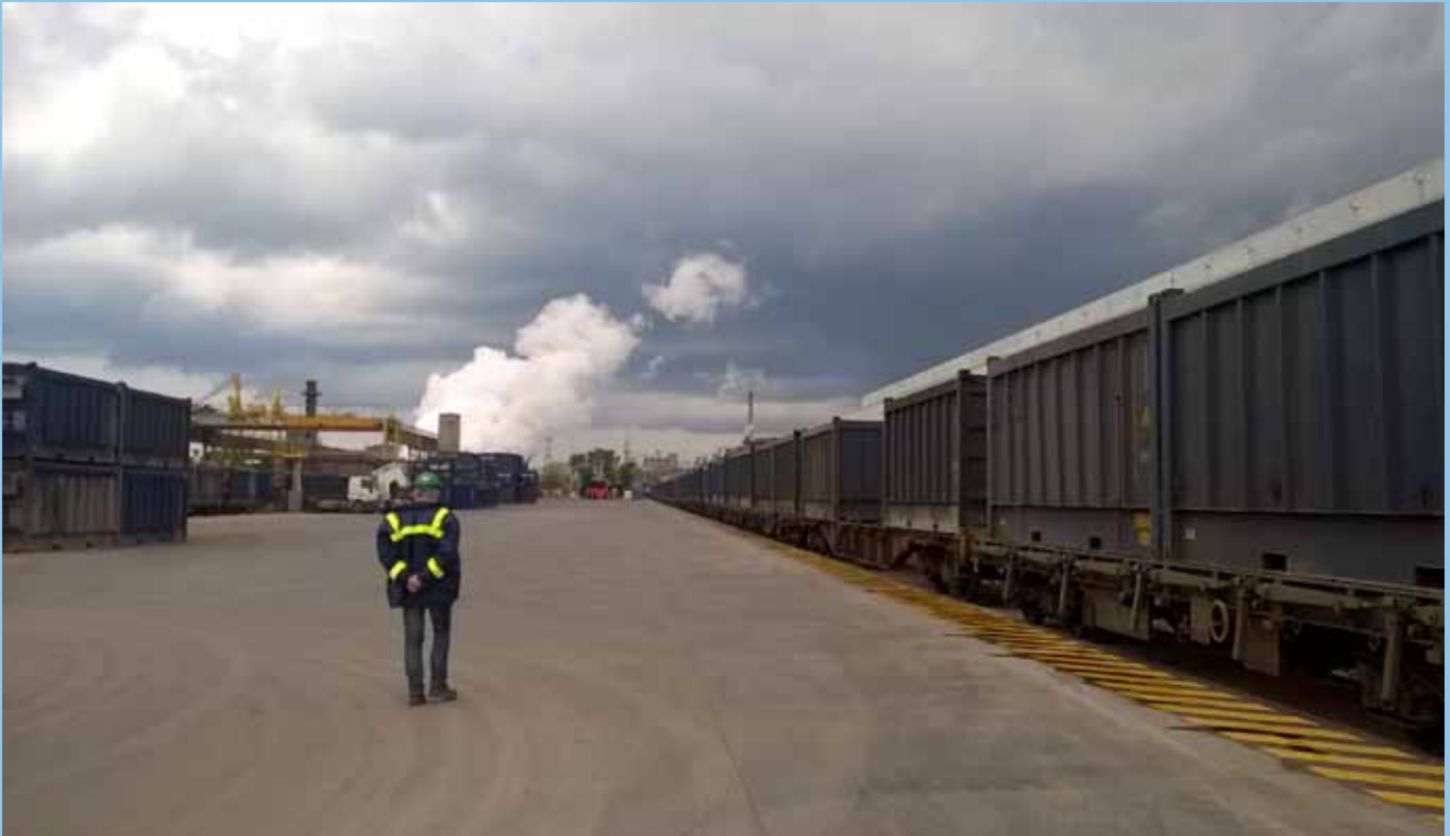
Figura 7: aree pavimentate nello stabilimento di Servola come attività di messa in sicurezza operativa dei suoli.
