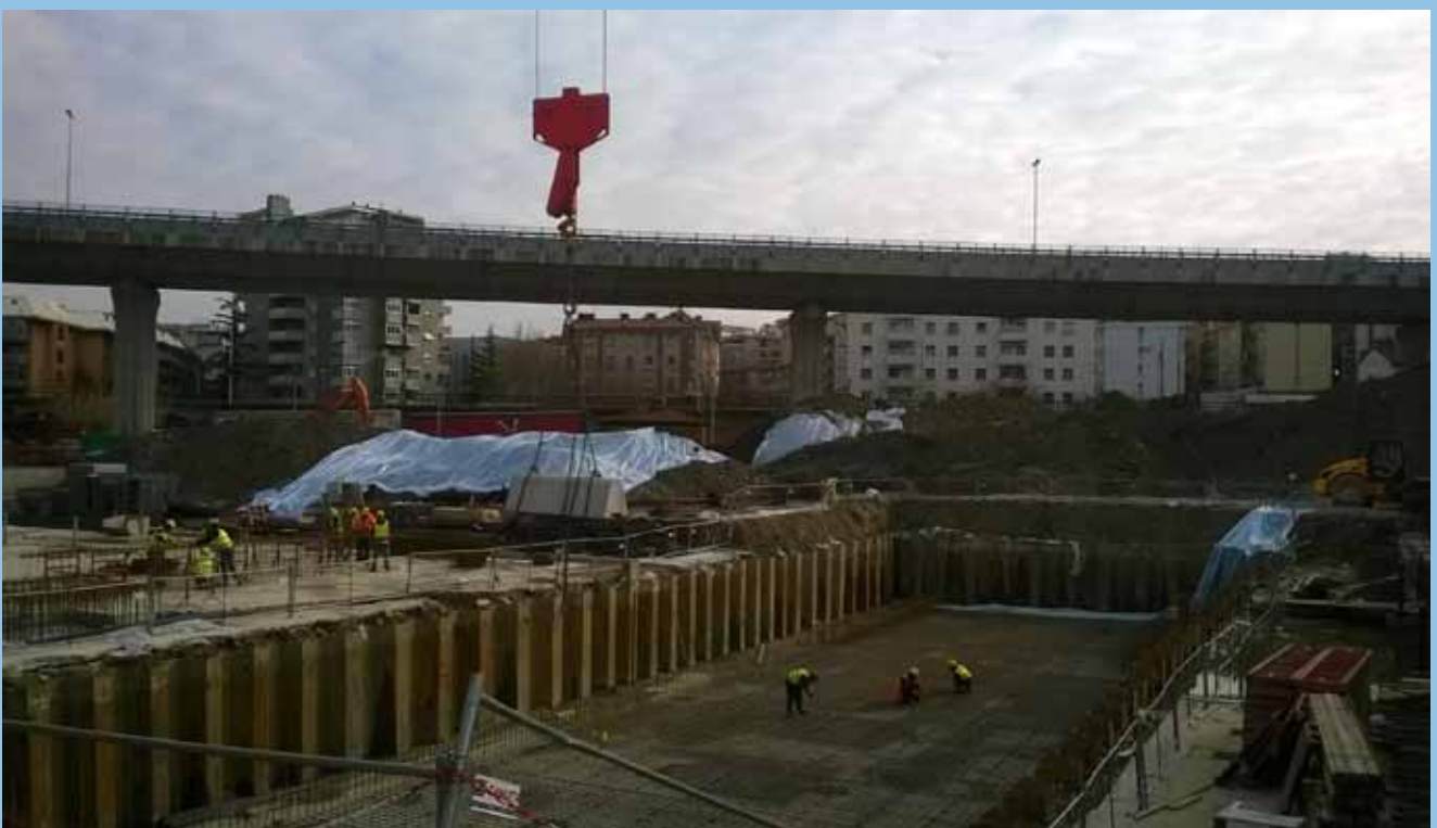
Figura 8: realizzazione del depuratore di Servola successivo alle operazioni di bonifica dei suoli.
